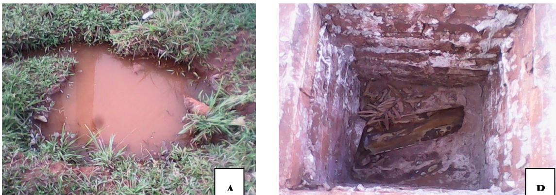
Figura 2. Detalhes de uma caixa de passagem afogada (A) e uma tubulação quebrada (B).
