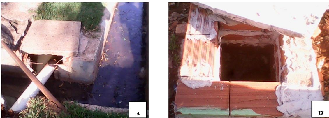
Figura 1. Detalhe do canal de água pluvial de escoamento livre com incremento de esgoto doméstico (A) e caixa de passagem com tampa inapropriada (B).
